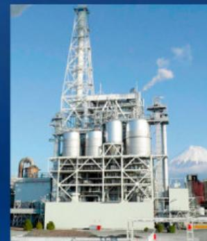
循環流動層ボイラ（CFBボイラ）を中核設備とした発電プラントは、従来は高効率利用が困難であったバイオマス燃料、廃棄物系燃料などの多様な燃料から電気、蒸気を作り出します。
